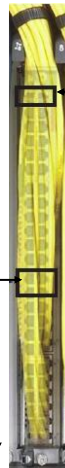
Cisco Nexus7010 スイッチ: 外側から内側のスロットに向かって配線
