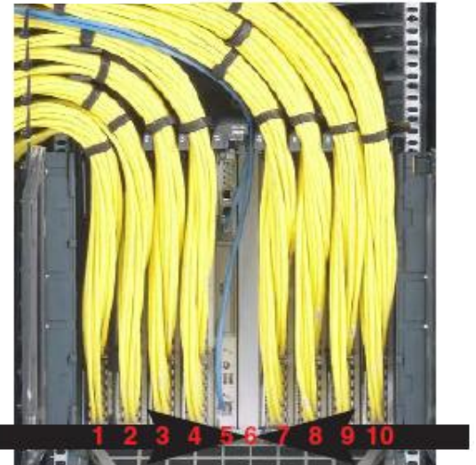
Cisco Nexus7010 スイッチ: 外側から内側のスロットに向かって配線
