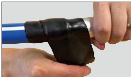
マスタックテープ幅の半分を目安に直線接続（銅側）へ重ねて巻く。
