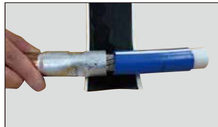
直接接続（アルミ側）からマスタックテープで絶縁、防水加工を実施。巻きの回数は1回でOK。
