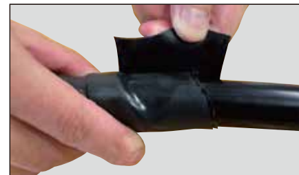
終端も電線外被覆（3cm分）を覆うようにして巻き仕上げをする。
