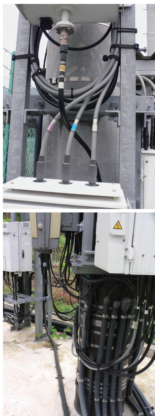
通信工事 (携帯電話用給電線の結束)
