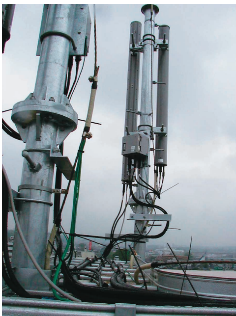
通信工事 (携帯電話用給電線の結束)
