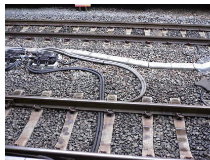
鉄道工事 (地上配線等の結束)
