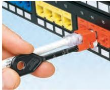
工具の白いラインをパッチコードロックの白いラインに合わせて挿入します。工具を時計回りに180度回転させて、そのままの状態引き抜きます。
