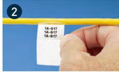
ラベル最上部の粘着部(アンカー)をケーブルに貼り付ける。その際、ケーブルに対してまっすぐにラベルを取り付ける。
