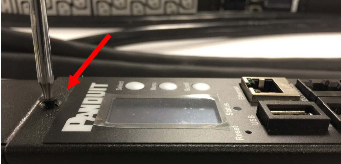
図67: 上下のネジをインテリジェントネットワークコントローラから取り外す
