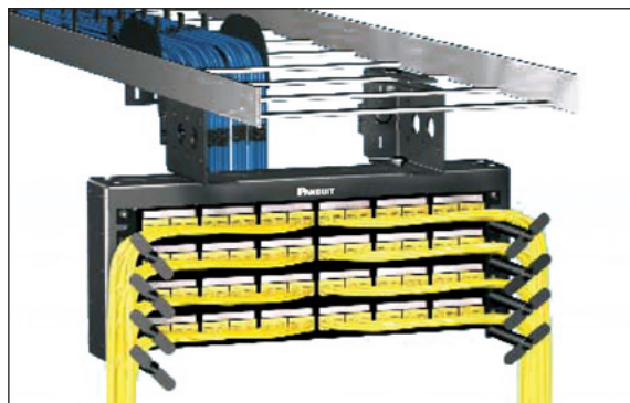
ラダーラックの下方で垂直向きに中央のラングに設置
